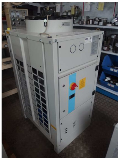
Grupo refrigeración agua 13588 frigorías/h.
